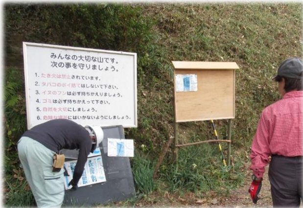
老朽化した掲示板を新しいものに交換
