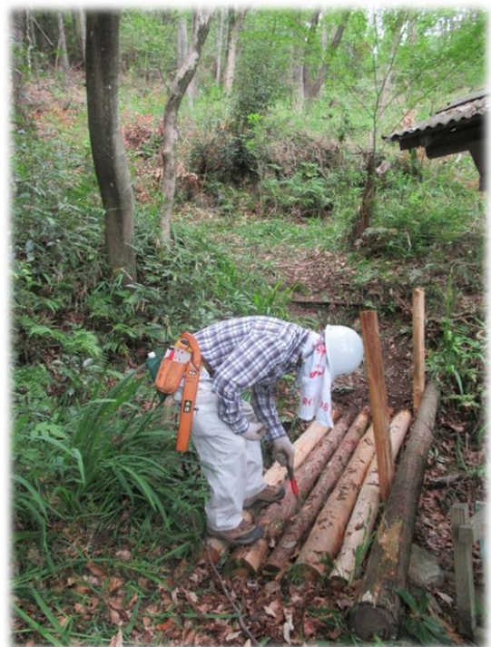
丸木橋の丸太を交換し、修復
