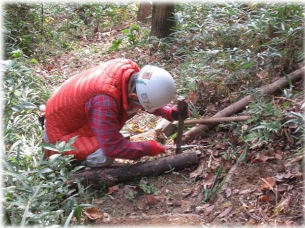
階段の丸太を支える杭を加工
