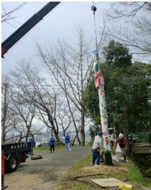
クレーン車で大ポールの設置
