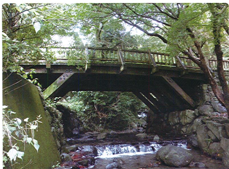
殿様も駕籠で渡りそうな橋 棕ヶ根橋 東豊浦町
